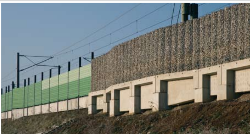
Anschlussbereich zur bestehenden ALU-Wand.
