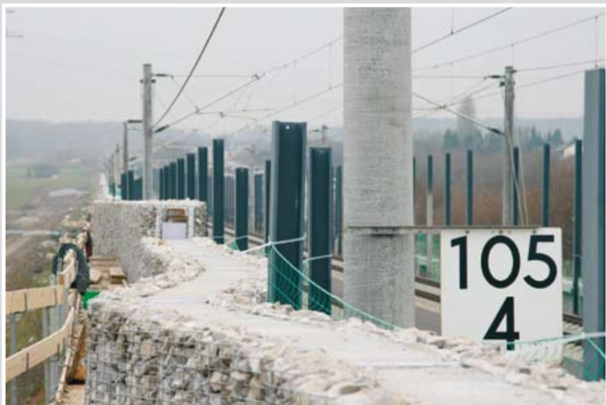
Das Rundkorbsystem ermöglicht problemlos wellenförmige Ausbuchtungen für die Mastumfahrung.
