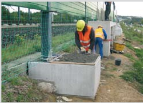
Betonieren der Auflagerbänke über den Bohrpfehlen in verloreener Schalung.
