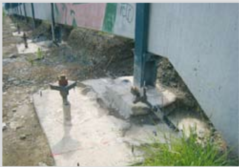
Gründung mit GEWI-Pfehlen und Sauberkeitsschicht für die Auflagerbänke.
