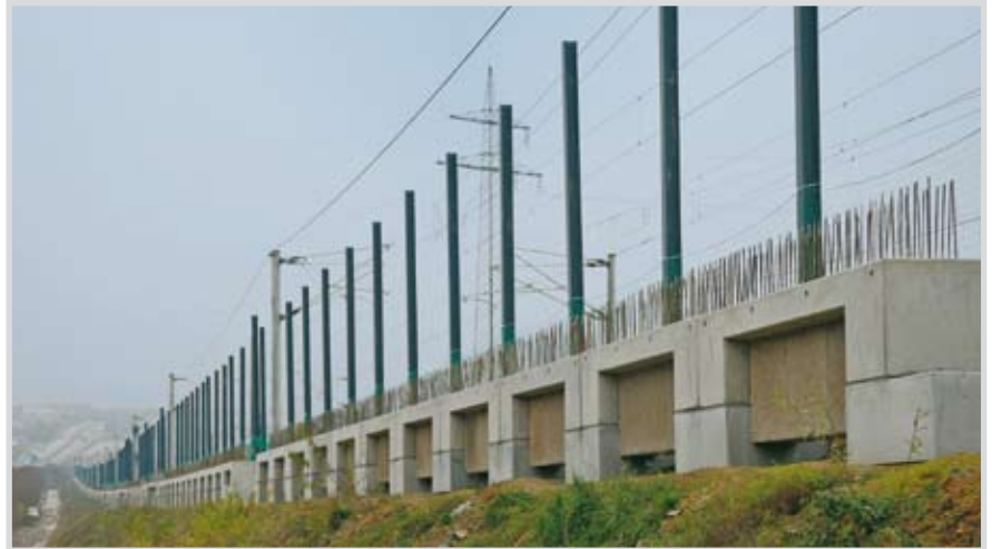
Die Stahlbetonfertigteilträger dienen zur Aufnahme der FERRONDO®-Lärmschutzwand. Die Holzspanbeton-Absorberplatten gewährleisten eine zusätzliche Schallschutzwirkung.
