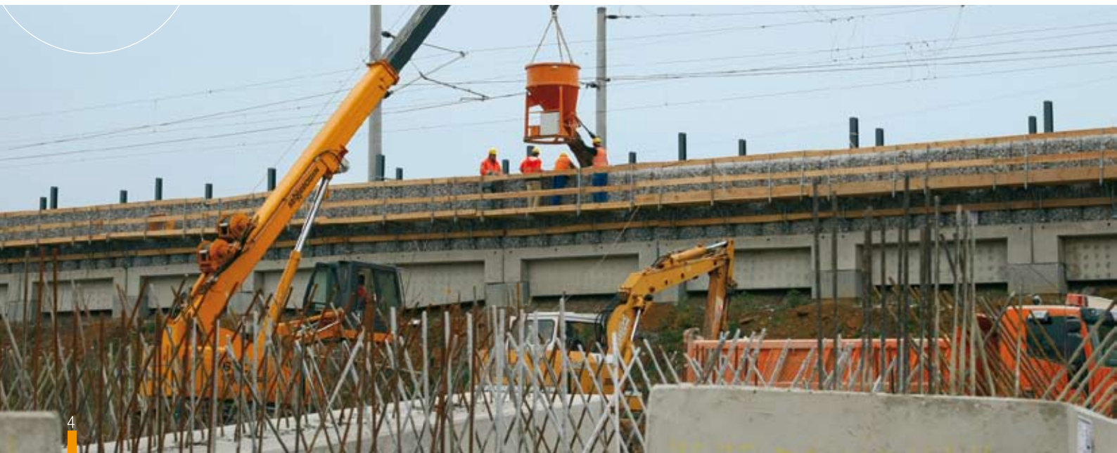
Befüllen der Rundkörbe mit Natursteinschotter (unten).
