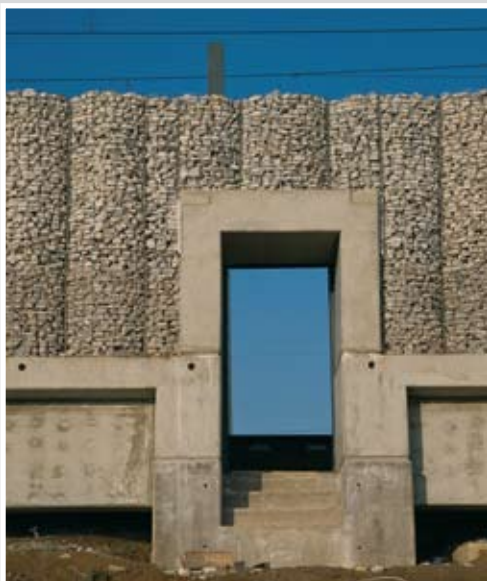
Ausführung der Fluchttüren durch Stahlbetonrahmenelemente.
