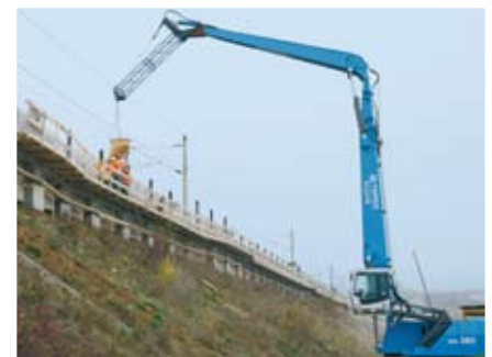
Ein spezieller Hebekran versorgt die Baustelle mit Material.
