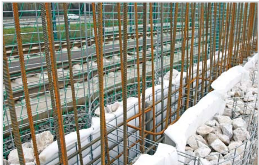
Anschlussbewehrung in dem Stahlbetonkern.
