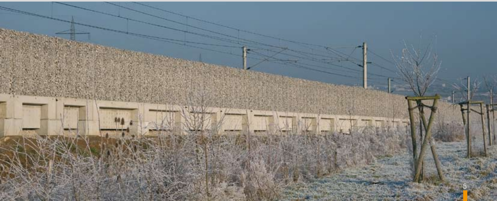
Ansicht der fertig gestellten FERRONDO®-Lärmschutzwand (unten).
