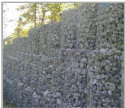
Mur de soutènement rempli de pierres naturelles.
