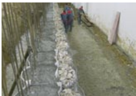
Les couches inférieures sont partiellement remplies de béton
