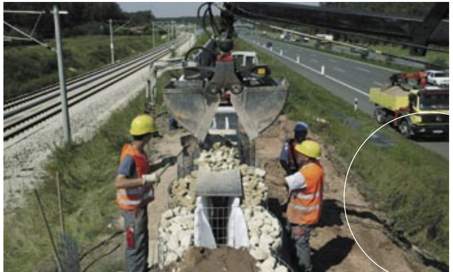
Construction rapide du mur anti-bruit le long du nouveau tronçon Nuremberg-Ingolstadt du train à grande vitesse allemand, l'ICE
