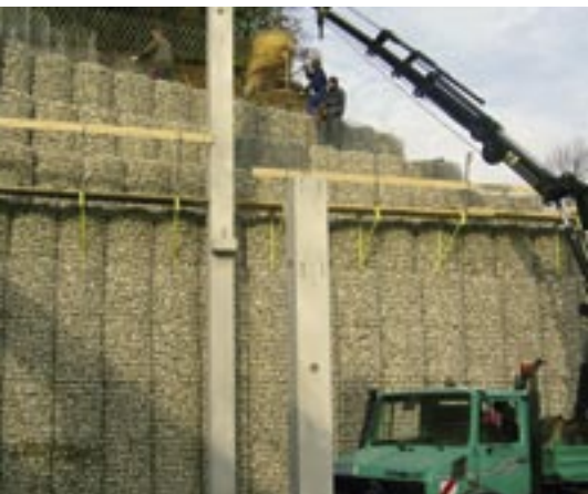
Un mur de soutènement de 11 m de haut à côté d'un centre commercial à Pegnitz en Bavière
