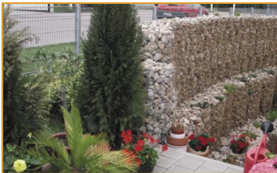
FERRONDO PICCOLO® e FERRONDO GRANDE® Formano un cortile (lucernaio) di un'abitazione
