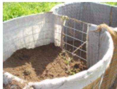
Die Stärke der Lagen kann so bemessen werden, dass ausreichende Verdichtung gewährleistet werden kann. Die Verfüllung kann deshalb sehr kostengünstig ausgeführt werden.
