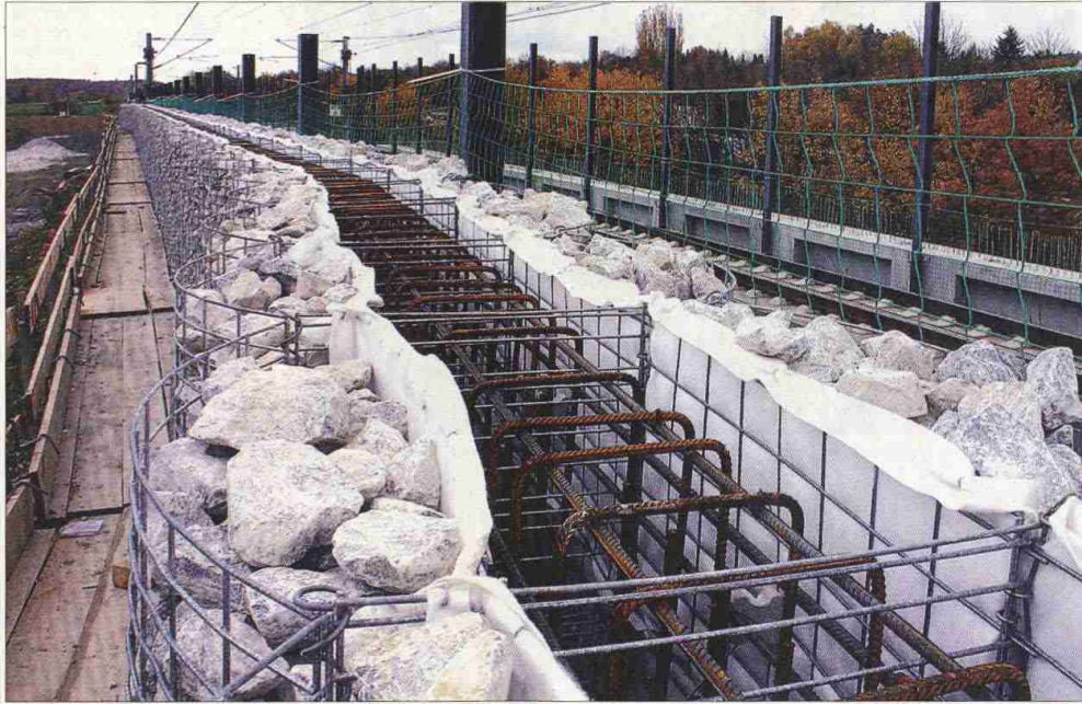
Links und rechts befinden sich Kalksteine in den Drahtkörben (Gabionen) der neuen Lärmschutzwand. In der Mitte sind Eisen zu sehen. Dort wird noch Beton eingefüllt. Foto: Günther
