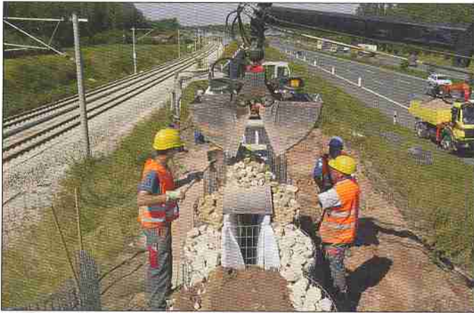
Abb. 3 und 4: Aufbau der Lärmschutzwand an der ICE-Strecke Nürnberg – Ingolstadt
