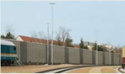
6,40 Meter hohe Lärmschutzwand an einem Bahnbetriebswerk in Schwandorf / Bayern
