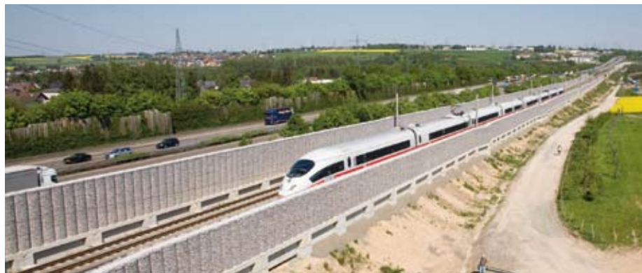
Beidseitig hochabsorbierende Wände an der ICE-Strecke Köln-Rhein/Main im Bereich Limburg
