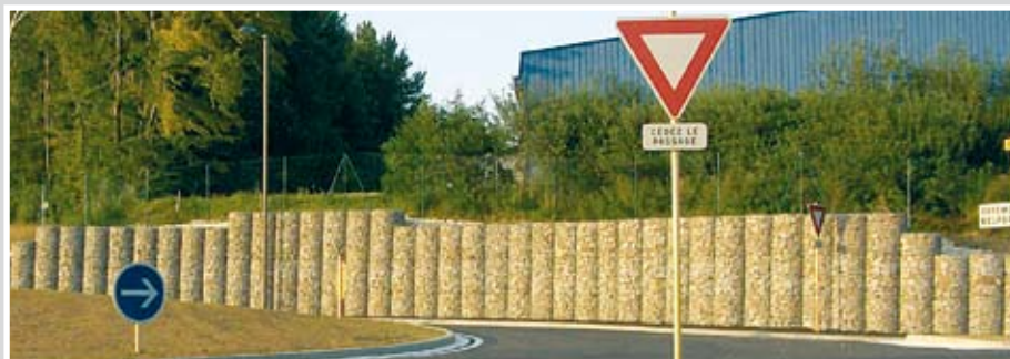
3 bis 4 Meter hohe Lärmschutzwand mit beidseitiger Steinfüllung und Betonkern in Weilburg / Hessen (u.)
