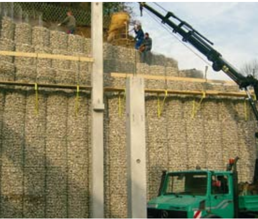
11 Meter hohe Böschungssicherung in direkter Nähe eines Einkaufszentrums in Pegnitz / Bayern
