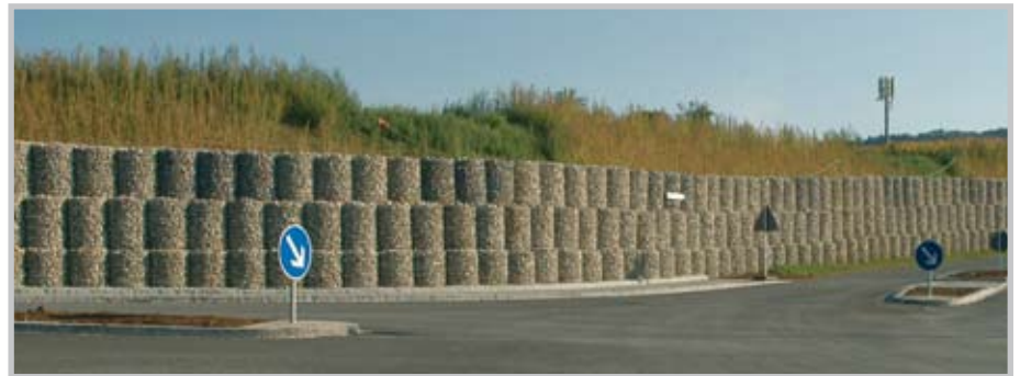
Böschungssicherung in Reichenschwand: FERRONDO® passt sich jeder Geländeformation an (o.)
