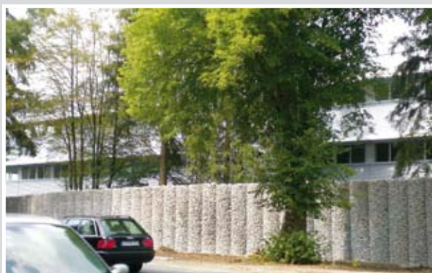
3 bis 4 Meter hohe Lärmschutzwand mit beidseitiger Steinfüllung und Betonkern in Weilburg / Hessen (u.)
