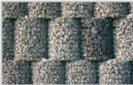
Ausschnitt aus der Lärmschutzwand in Langenselbold: Der Materialmix gibt den optischen Kick (o.)
