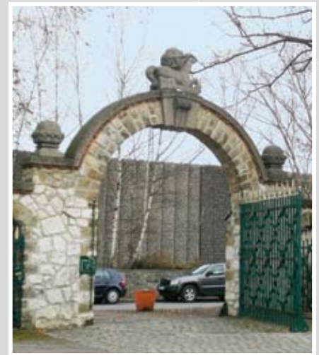
Die im Kern mit bewehrtem Beton und in den Ansichtsflächen mit Granit und Dolomit befüllten Körbe harmonisieren mit der historischen Architektur der Umgebung (ob.)
