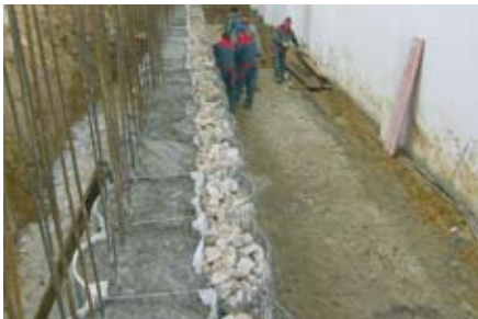
Die unteren Lagen werden teilweise mit Beton befüllt
