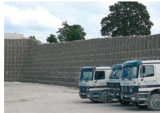
12 Meter hohe Stützmauer auf einem Betriebsgelände in Laaber/Bayern
