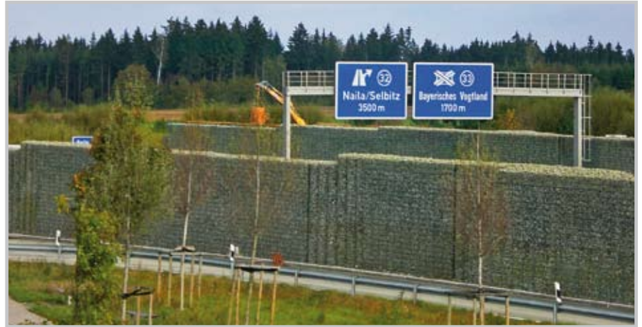
Hochwirksamen Schallschutz erzielen die 5 Meter hohen FERRONDO® -Wände durch den fugenlosen, durchgängigen Betonkern an der Autobahn A9 im Bereich PWC Lipperts (ob.)
