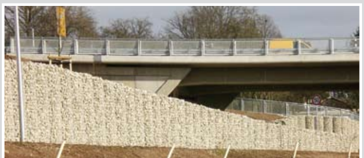
Böschungssicherung an einer Bundesstraße in Zirndorf / Bayern ( u.)
