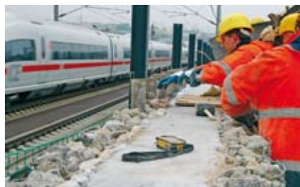
Während der gesamten Bauzeit bleibt der Zugverkehr unbeeinträchtigt.
