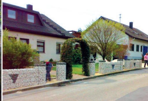
Die Gitter werden vor Ort schnell und einfach aufgebaut und mit einem frostsicheren Stein oder Glasbruch befüllt.
